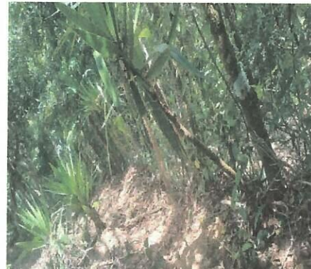
Foto 4: Se realizará el muro perimetral
